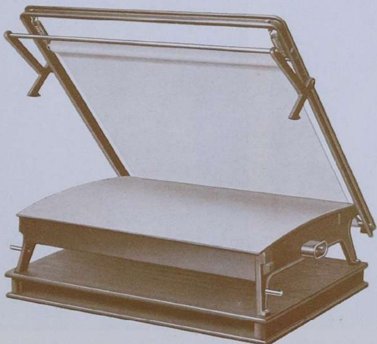
ماشین خشک کردن و برق انداختن عکسها که در هر ساعتی سیصد قطعه عکس شش در نه را خشک نموده یراق میکند
